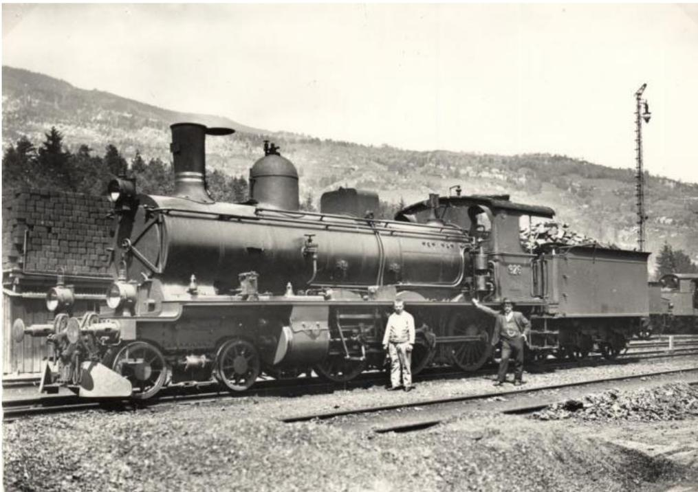
**GB (SBB Version) A 3/5 no 926 aus der vierten Serie zeigt deutlich das gerade Umlaufblech und die 2 Ringe am Kamin; Maschine aus der vierten Serie (wie Lok no 225 unsere Art.no. für die GB-Version 2278/4 und für die SBB/CFF Version Art.no.: 2278/9**
